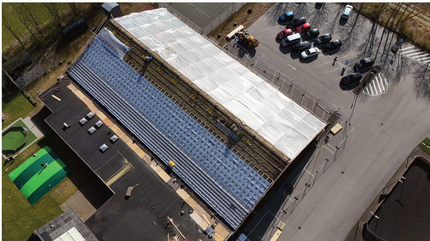
Det går planmæssigt med udskiftningen af taget på Glejbjerg Fritidscenter. Foto: Brian Nielsen
