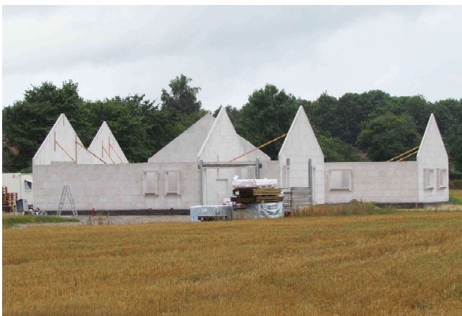
Nybyggeri på Byagergårdsvej.
